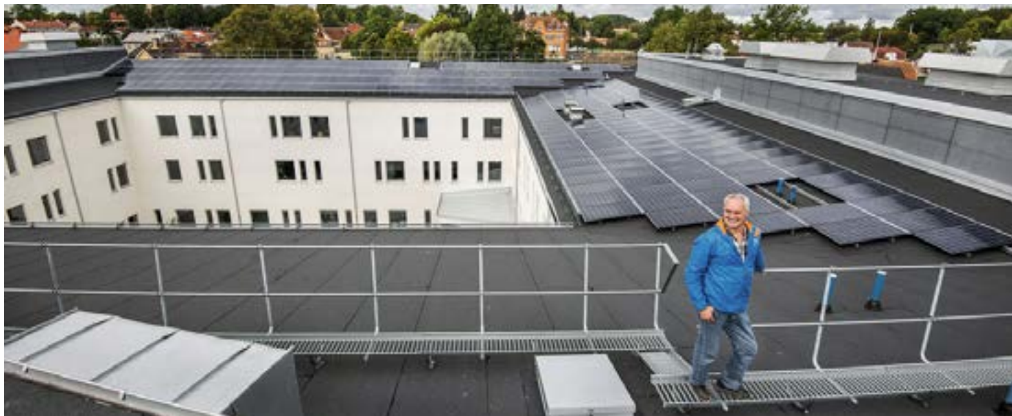
I kulturcentrumet Sjöängen i Askersund byggs ett lokalt integrerat energisystem som omfattar solenergi, batterilagring, energistyrning och laddning av elbil. På bilden affärsutvecklare Lars-Göran Karlsson, Vattenfall Eldistribution. Foto: Per Knutsson
