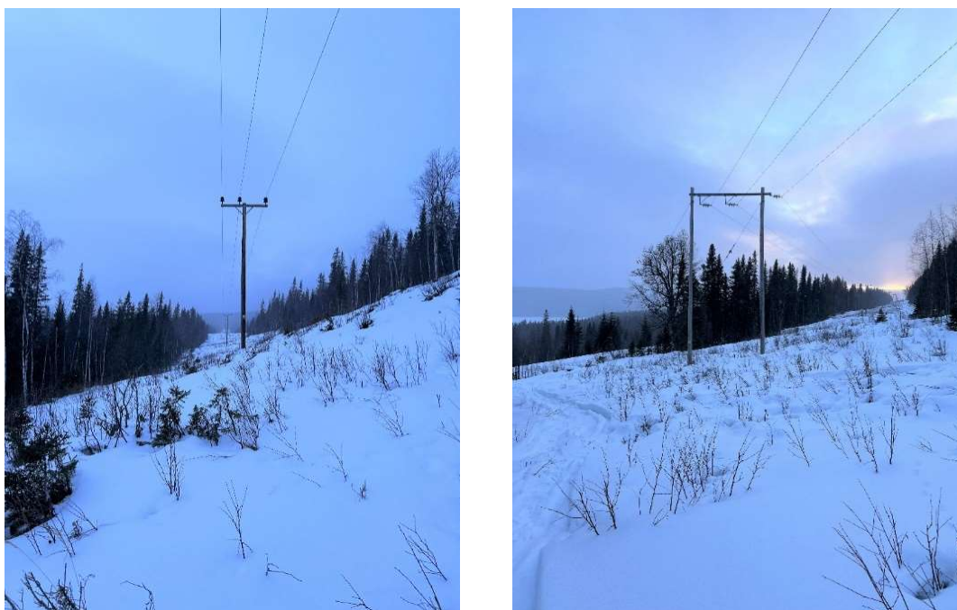
Figur 3. Exempel på enkelstolpe vid raklinje och parstolpe vid vinkel.
