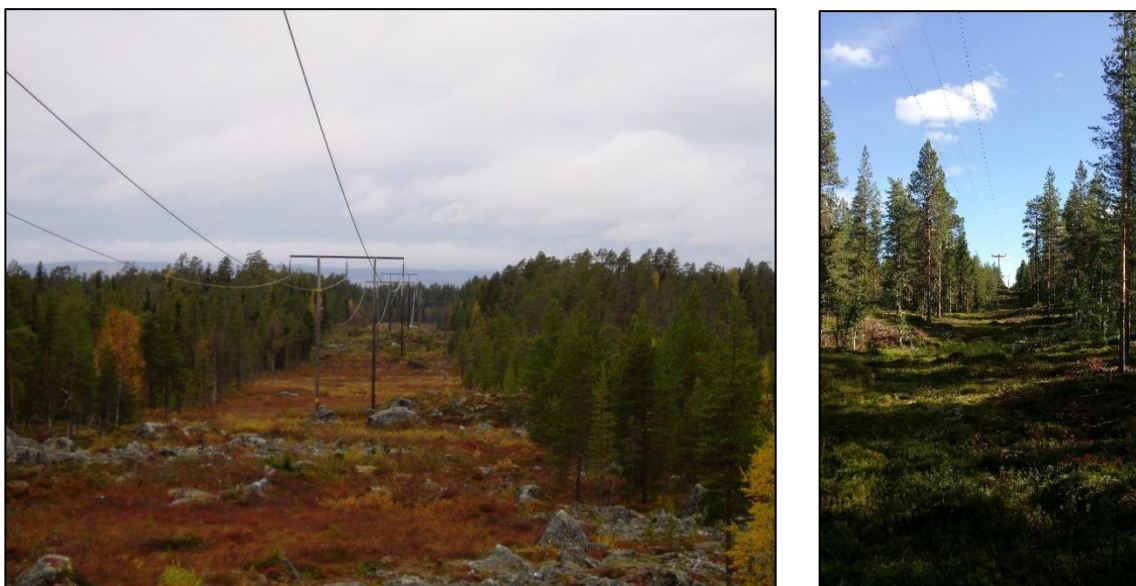
Figur 2. Foto över trädsäker 130 kV luftledning i regionnätet till vänster samt ej trädsäker 20 kV luftledning i lokalnätet till höger.
