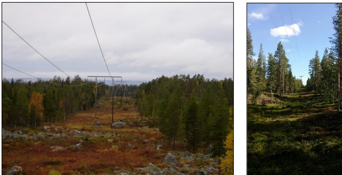
Figur 7. Foto över trädsäker 130 kV luftledning i regionnätet till vänster samt ej trädsäker 20 kV luftledning i lokalnätet till höger.
