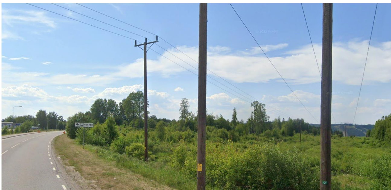
Figur 9. Landskap i området runt ny och befintlig ledningsgata (40 kV till vänster i bild och 130 kV till höger).
