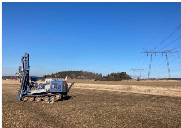
Bild 2: Borrbandvagn som används vid geotekniska markundersökningar
