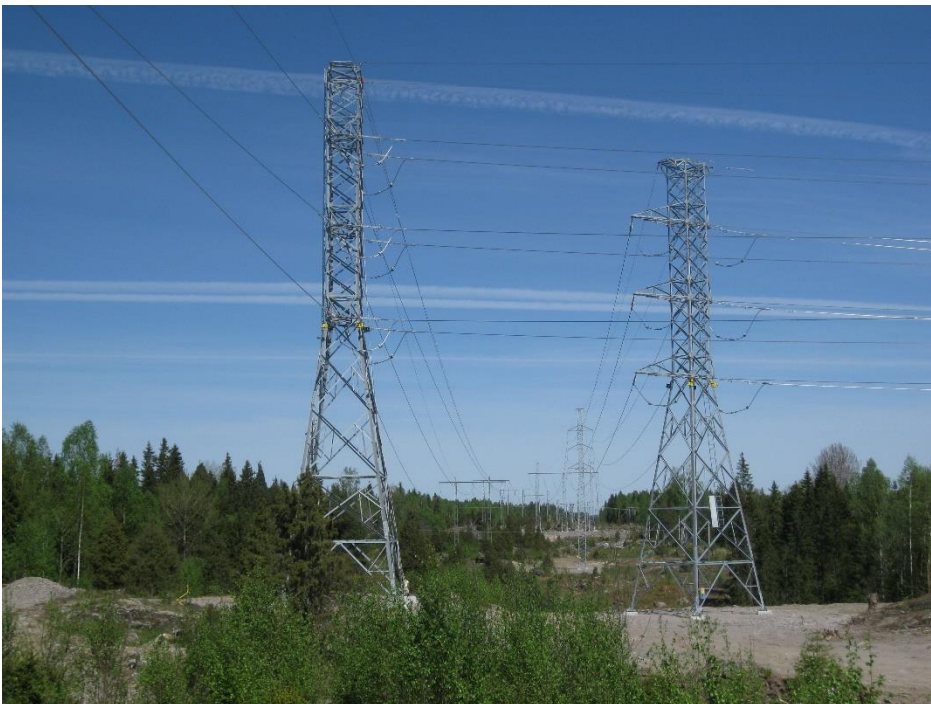
Figur 9. Fotoexempel på vinkelstolpe i stål i förgrening.
