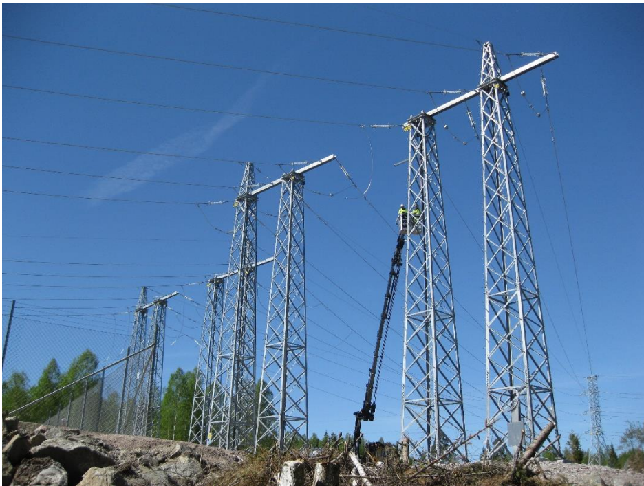
Figur 10. Fotoexempel på ändstolpe i stål.
