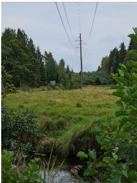
Figur 10. Landskap runt befintlig ledning OL8 S7 mellan Uddebo-Solhem.
