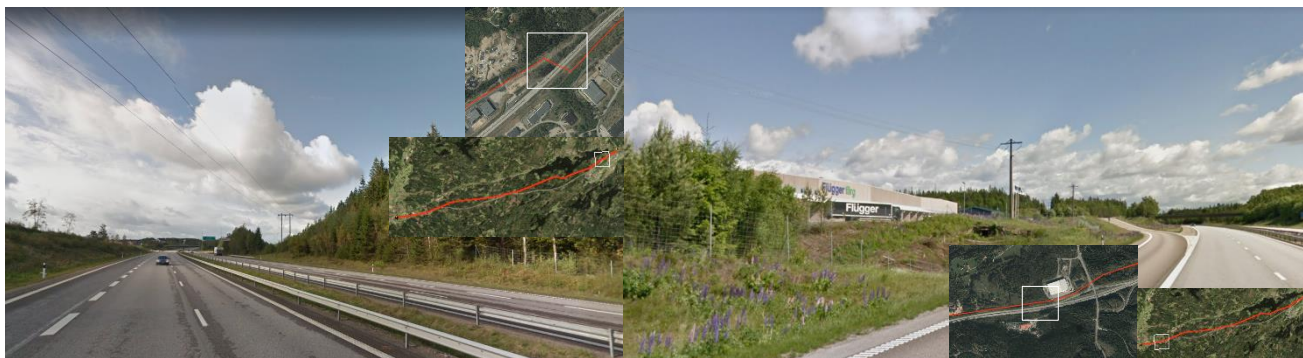
Figur 5. T.v. Ledningen korsar väg 40 i öst. T.h. Ledningen är synlig från Väg 40.
