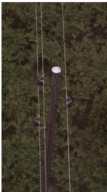
Figur 3. Foto enbenta trästolpar med triangelkonfigurering.
