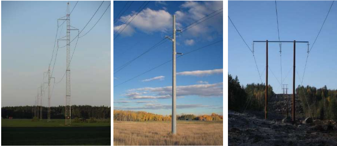
Figur 10. Exempel på olika stolptyper. Till vänster; gitterstolpe, i mitten; kompositstolpe och till höger; trästolpe.
