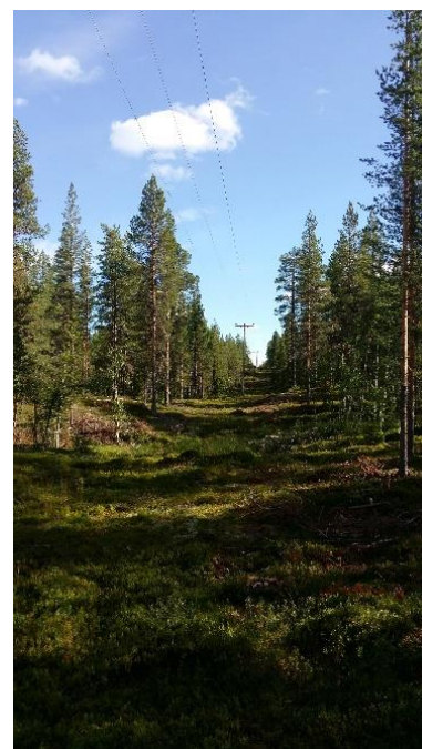
Figur 5. 20 kV luftledning i lokalnätet, ej trädsäker.
