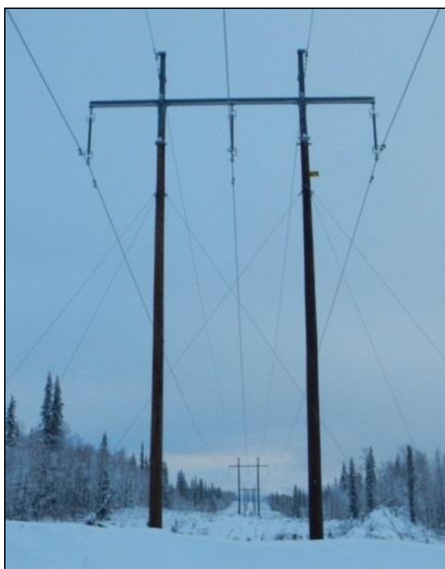
Figur 3. Bild till vänster på 220 kV ledning i portalstolpe i stål. Bilden till höger är en 150 kV ledning i träportalstolpe.
