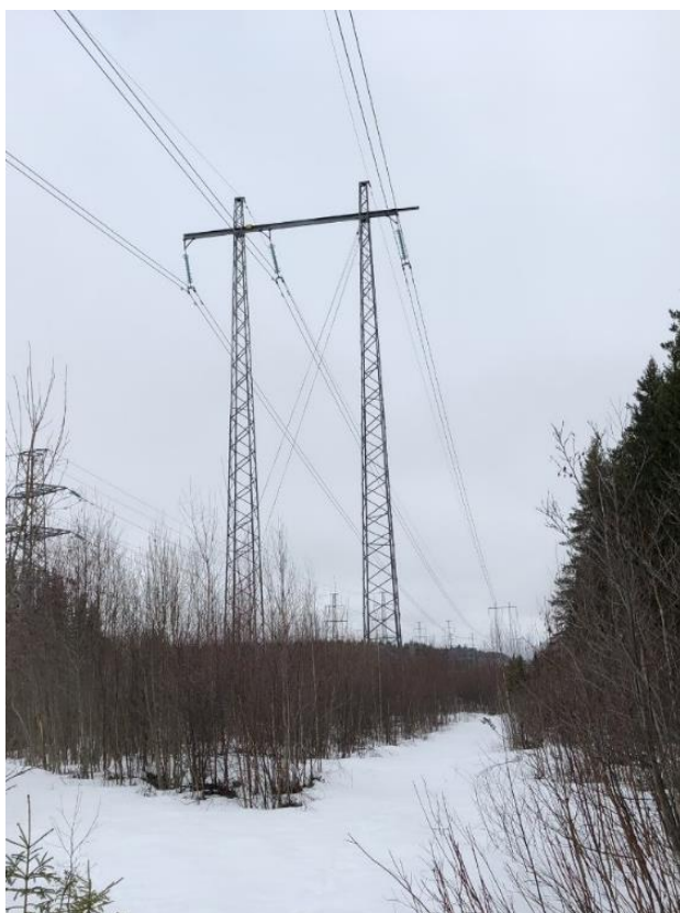
Figur 3. Bild till vänster på 220 kV ledning i portalstolpe i stål. Bilden till höger är en 150 kV ledning i träportalstolpe.
