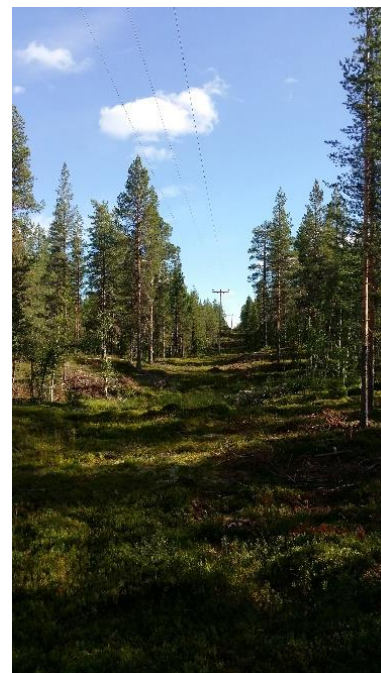
Figur 2. 20 kV luftledning i lokalnätet, ej trädsäker.
