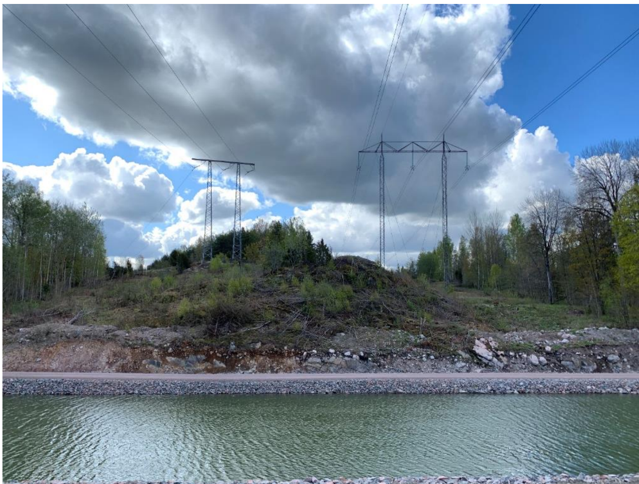
Figur 4. Vattenfall Eldistributions befintliga ledning ML9 S6 till vänster i bild. Svenska Kraftnäts 400 kV ledning till höger i bild. Göta kanal syns i förgrunden. Fotot är taget åt söder.
