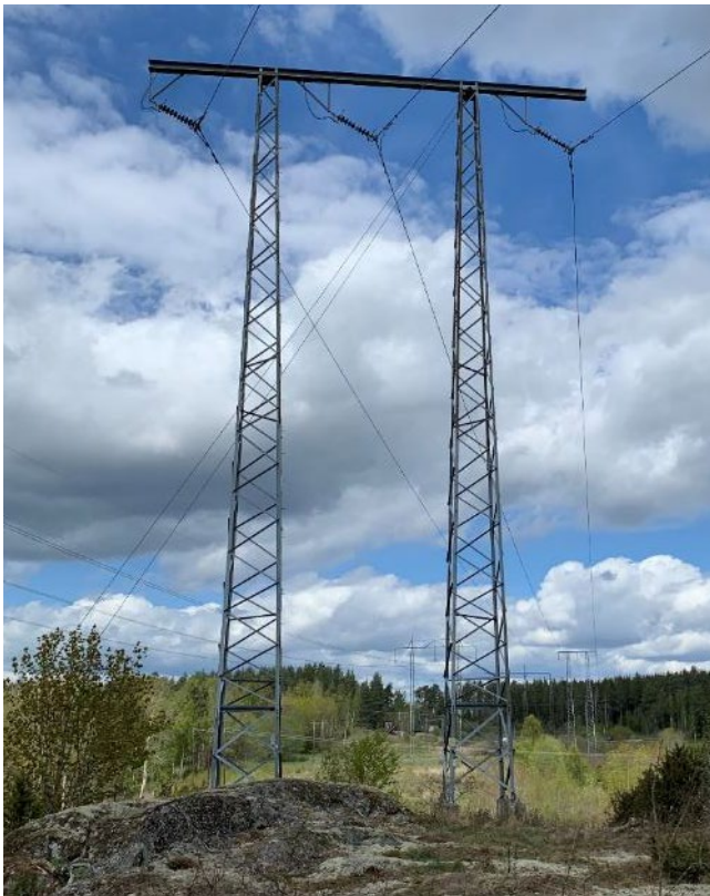
Figur 8. Stålstolpe i portalutförande.
