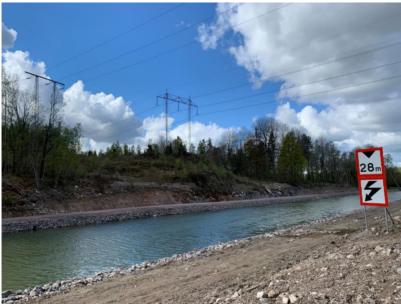
Figur 5. Vattenfall Eldistributions befintliga ledning ML9 S6 där den korsar Göta Kanal. Svenska Kraftnäts 400 kV ledning till höger i bild. Göta kanal syns i förgrunden. Fotot är taget åt sydöst.
