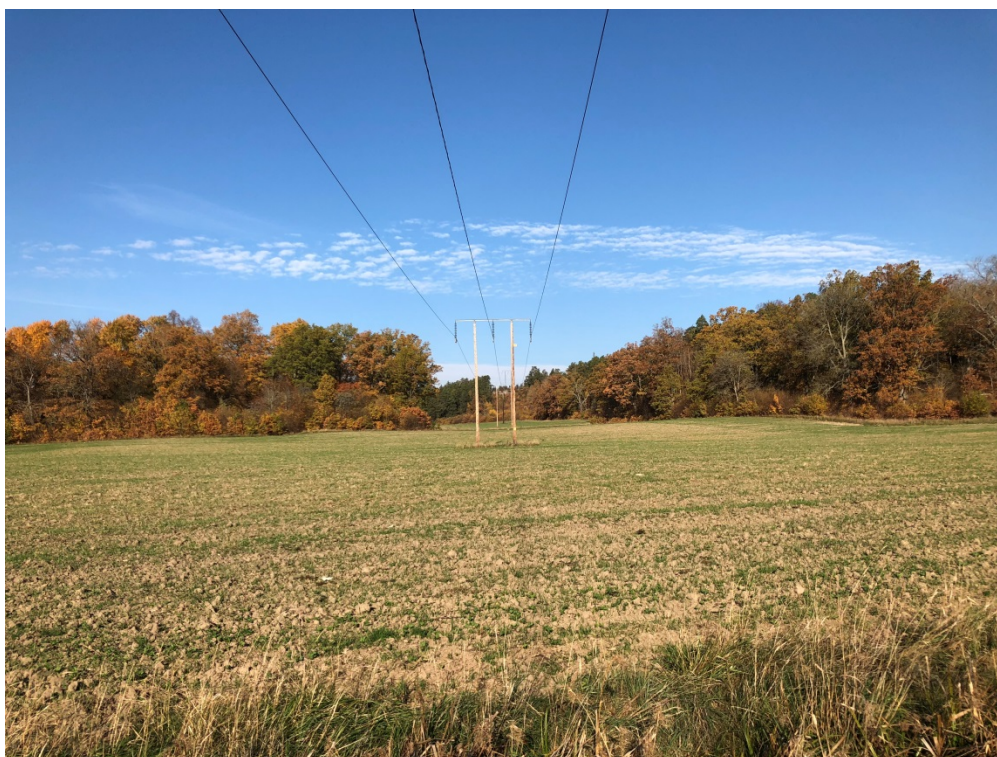
Figur 9 Foto är taget i nord-östlig riktning i befintlig ledningsgata.
