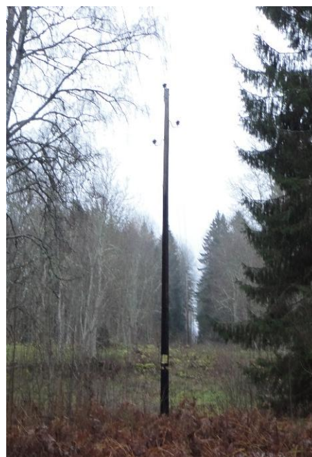
Bild 8–9: Foto över de enkelstolpstyper i trä som förekommer på sträckan.
