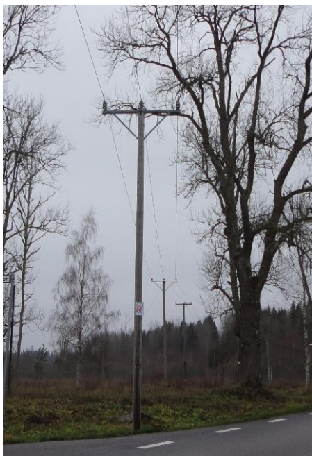
Bild 8–9: Foto över de enkelstolpstyper i trä som förekommer på sträckan.
