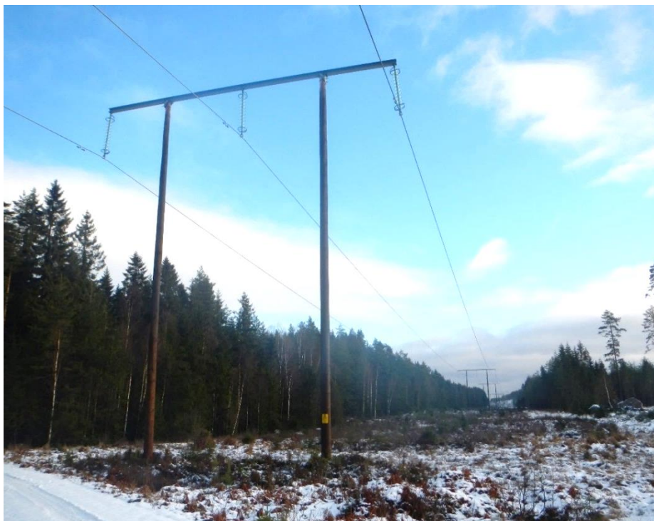
Figur 11. Ledning RL6S i portalstolpsutförande.
