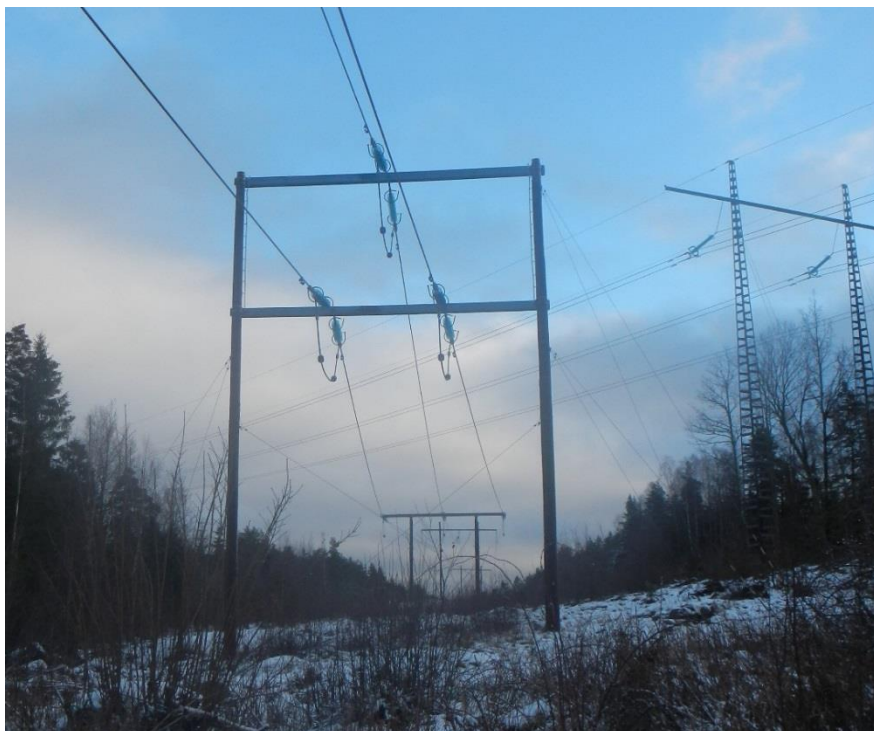
Figur 12. RL6S2 i kompaktsstolpsutförande sydost om Vretstorp.
