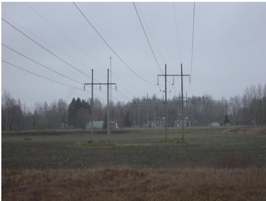
Bild 3. Foto över befintlig 77 kV portalstolpe i trä till vänster i bild.
