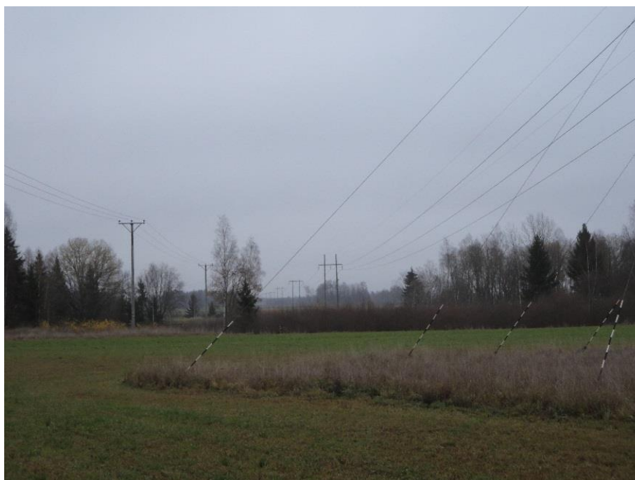
Bild 1. Foto över befintliga ledningars sträckning genom i huvudsak öppen jordbruksmark. Ledningen till vänster i bild utgörs av befintlig 22 kV ledning och ledningen till höger befintlig 77 kV ledning.
