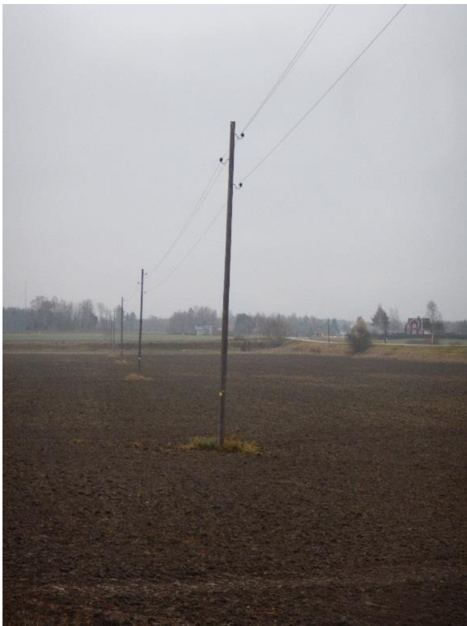
Bild 2. Foto över befintlig 10 kV lokalnätledning.
