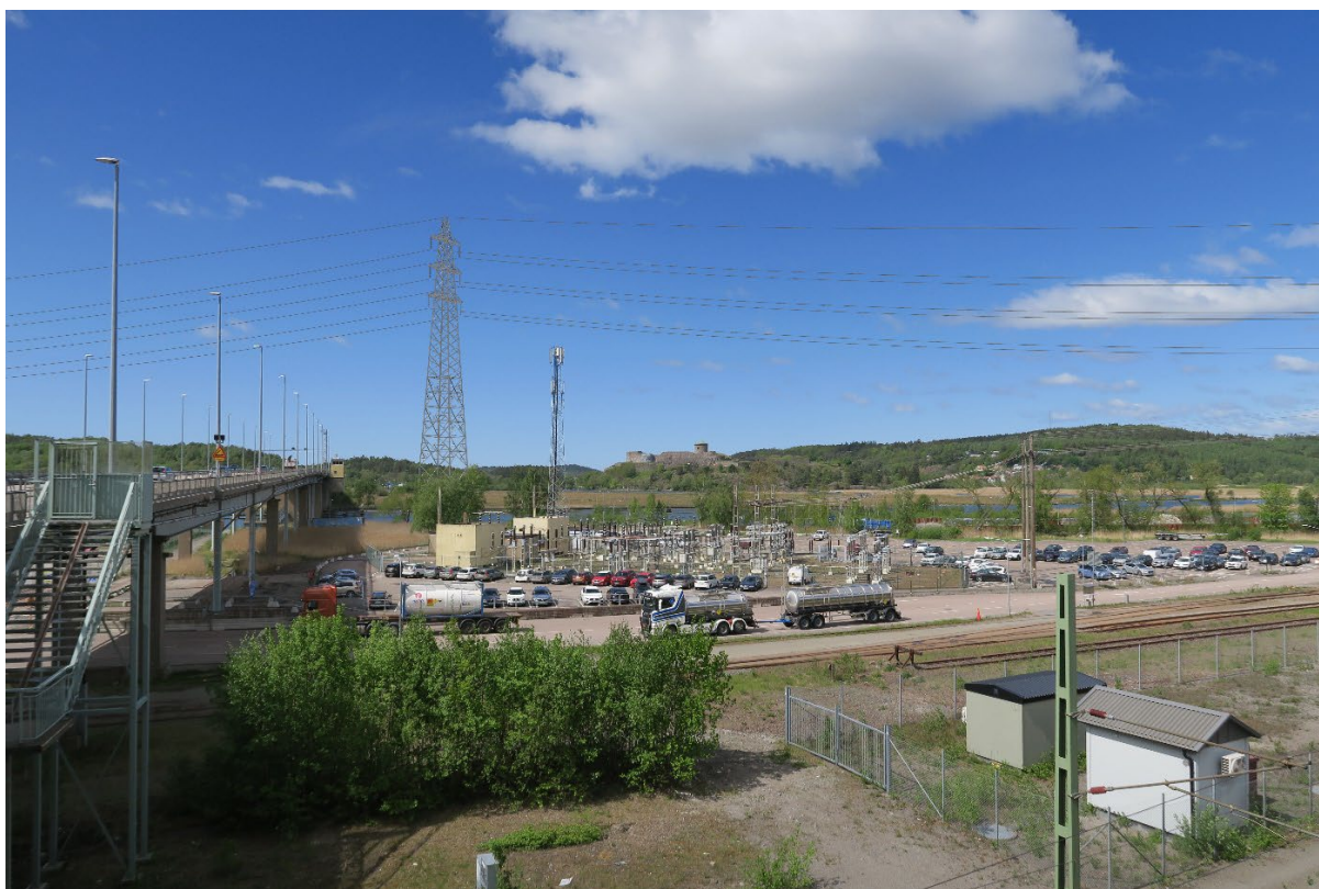
Figur 20. Visualisering av 130 kV-ledningen, vy över Göta älv mot Bohus fästning, se fotopunkt 2 i Figur 18. Stolphöjd i visualiseringen är ca 55 meter. Visualisering framtagen av WSP Sverige AB.
