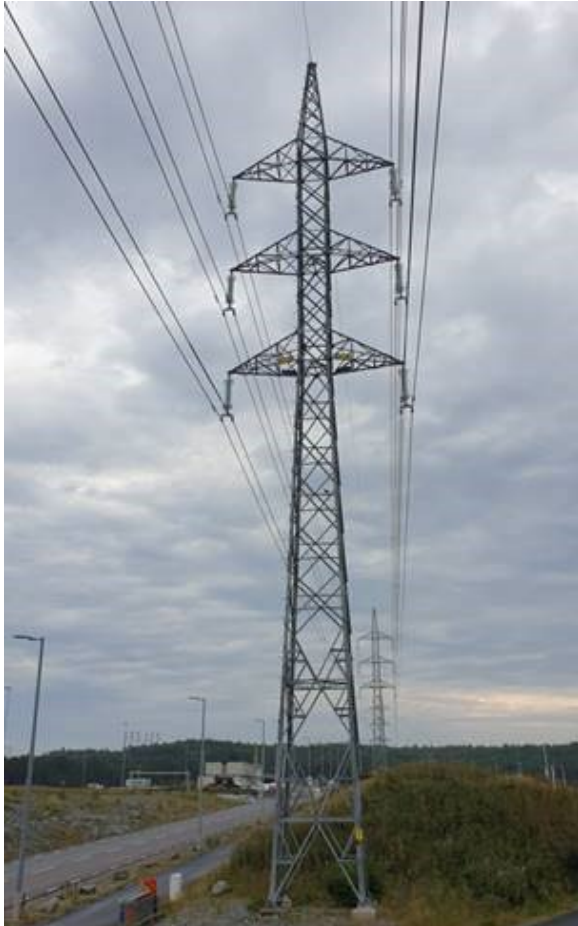
Figur 10. Exempel på stolptyper som kan vara aktuella för 130 kV-ledningar. Från vänster: Fackverksstolpe av stål för dubbelledning och portalstolpar i trä för befintliga 130 kV-ledningar.
