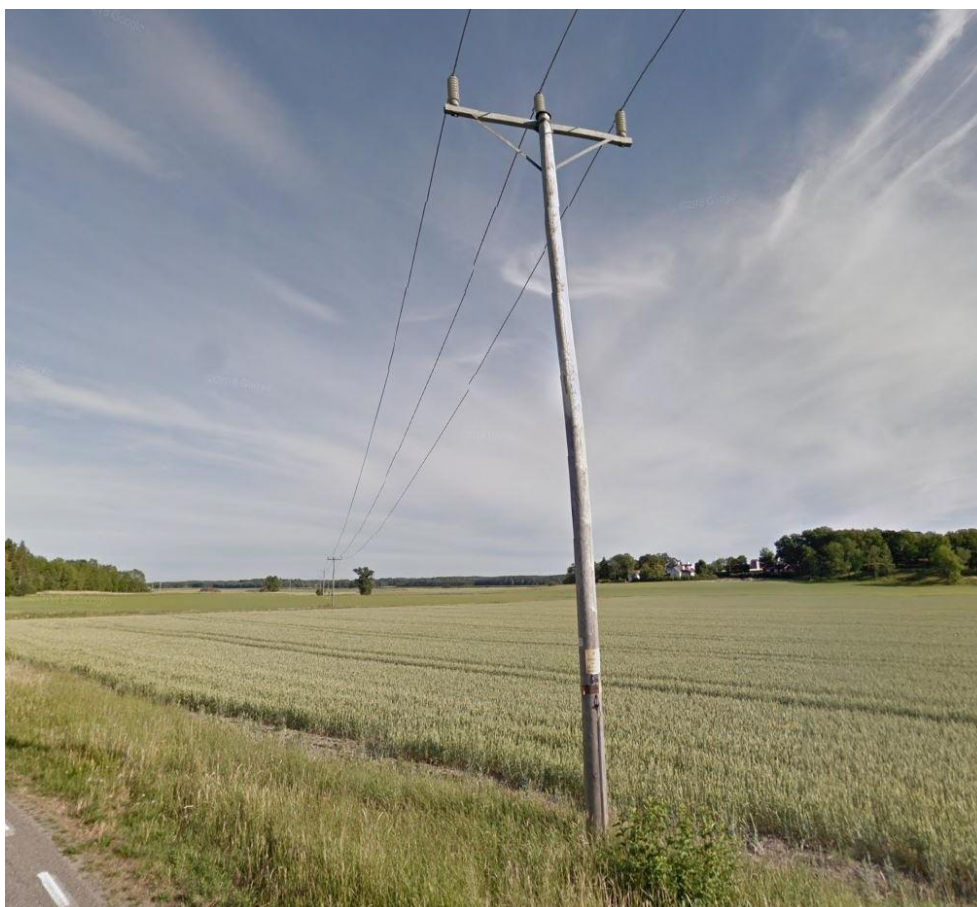
Figur 11. Befintlig ledningen genom jordbrukslandskapet i södergående riktning från väg 960. Foto: © Google Maps.
