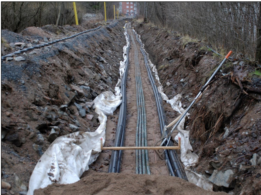
Figur 28. Exempelfoto på kabelschakt.
