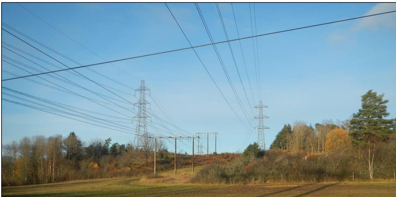
Figur 12. Foto över befintliga luftledningar på delsträcka 1, fotoriktning norrut. Från vänster: Svenska kraftnäts två 400 kV ledningar i fackverksstolpar, Sökandens två 70 kV ledningar L2 och L3 i träportalstolpar, Sökandens två 70 kV ledningar L1 och L4 i fackverksstolpar.
