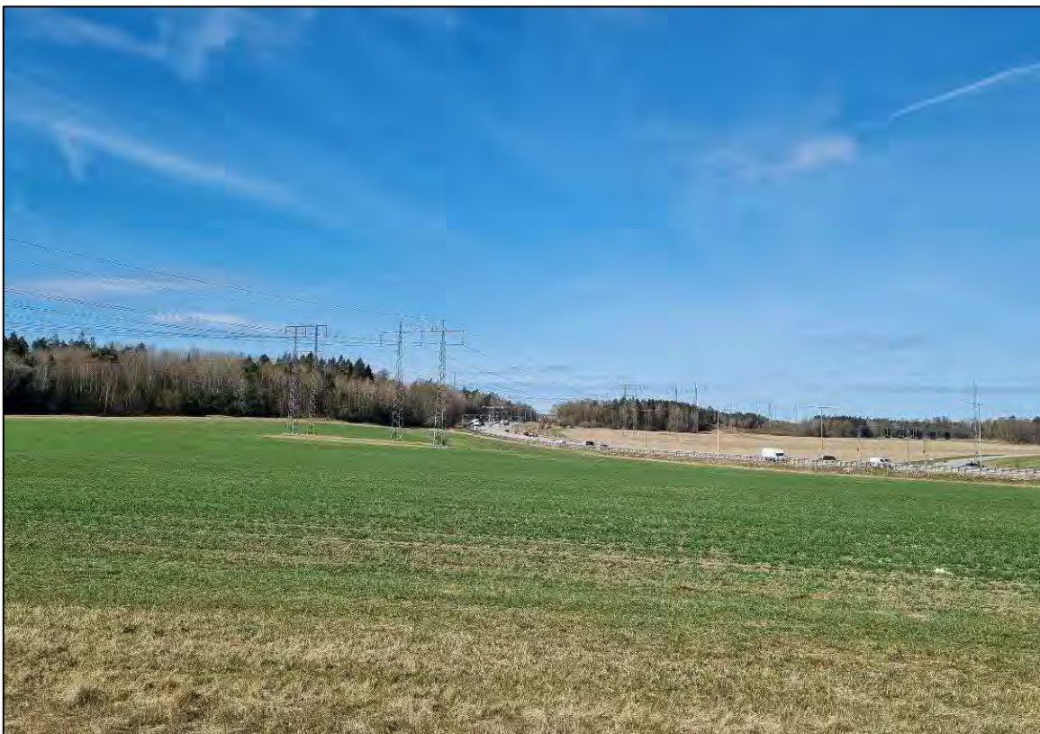
Figur 17. Foto över sambyggda 70- och 220 kV-ledningar Kolbotten-Lindhov (till vänster i befintlig ledningsgata) samt parallellgående 220 kV-ledning Kolbotten-Botkyrka vid passage över jordbruksmark tillhörande SVOA samt E4/E20.
