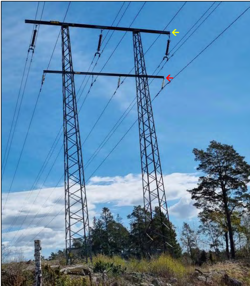
Figur 16. Foto över stålstolpe norr om Vretarna längs sträckan Lindhov-Tullinge villastad där befintlig 220 kV-ledning är sambyggd med Sökandens 70 kV-ledning. Linor längs den nedre regeln tillhör 70 kV-ledningen (röd pil) och linor längs den övre regeln tillhör 220 kV-ledningen (gul pil).
