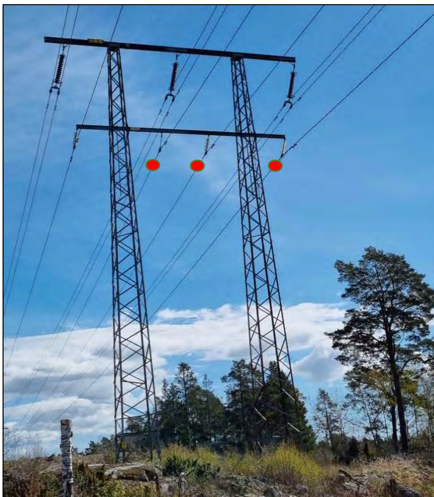
Figur 25 Ombyggnation av befintliga ledningar på sträckan Gatmötet-Tullinge villastad innebär att tre av fyra befintliga linor i den nedre regeln demonteras (röda punkter).
