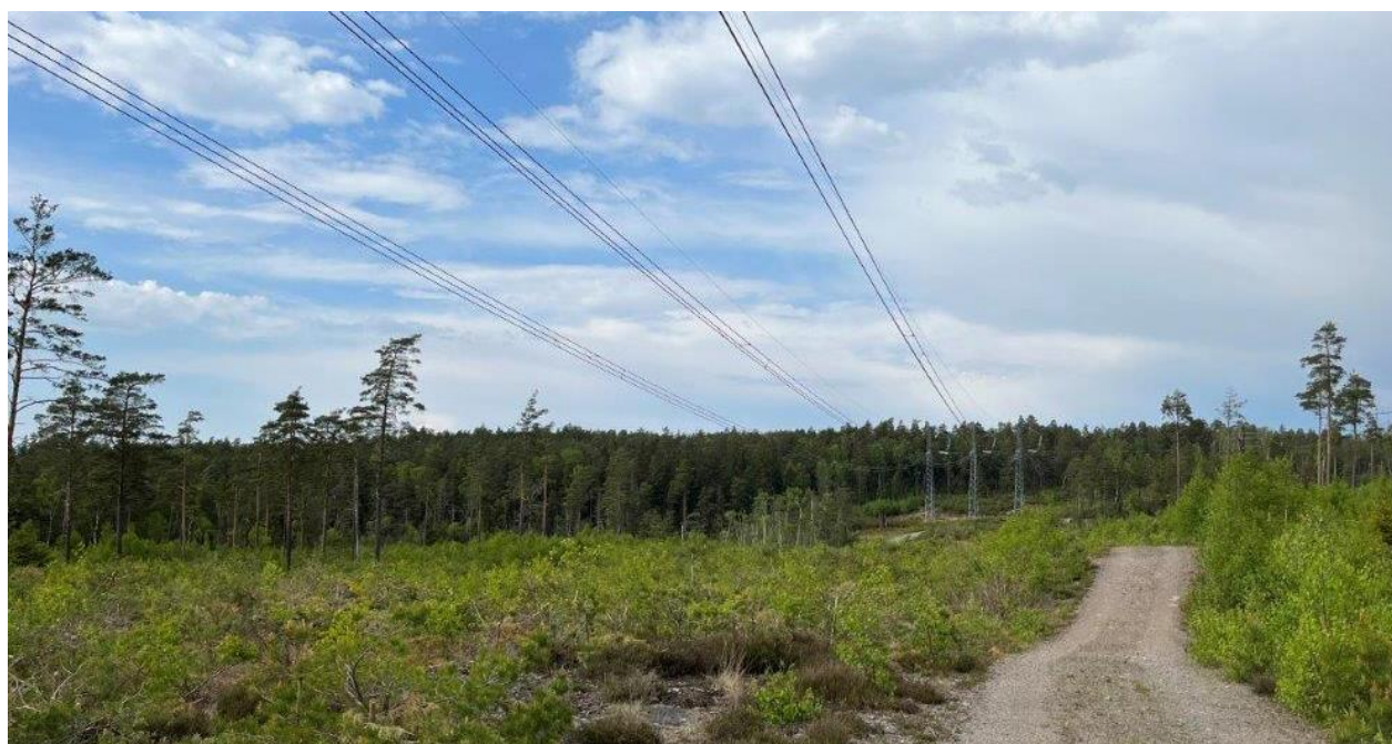
Figur 16. Befintlig 400 kV ledning i de södra delarna med mer öppen terräng. Skogsparti kan ses norr om ledningen. Bilden är tagen mot nordöst. Planerad 130 kV ledning föreslås att uppföras norr om befintlig 400 kV ledning, till vänster i bild.
