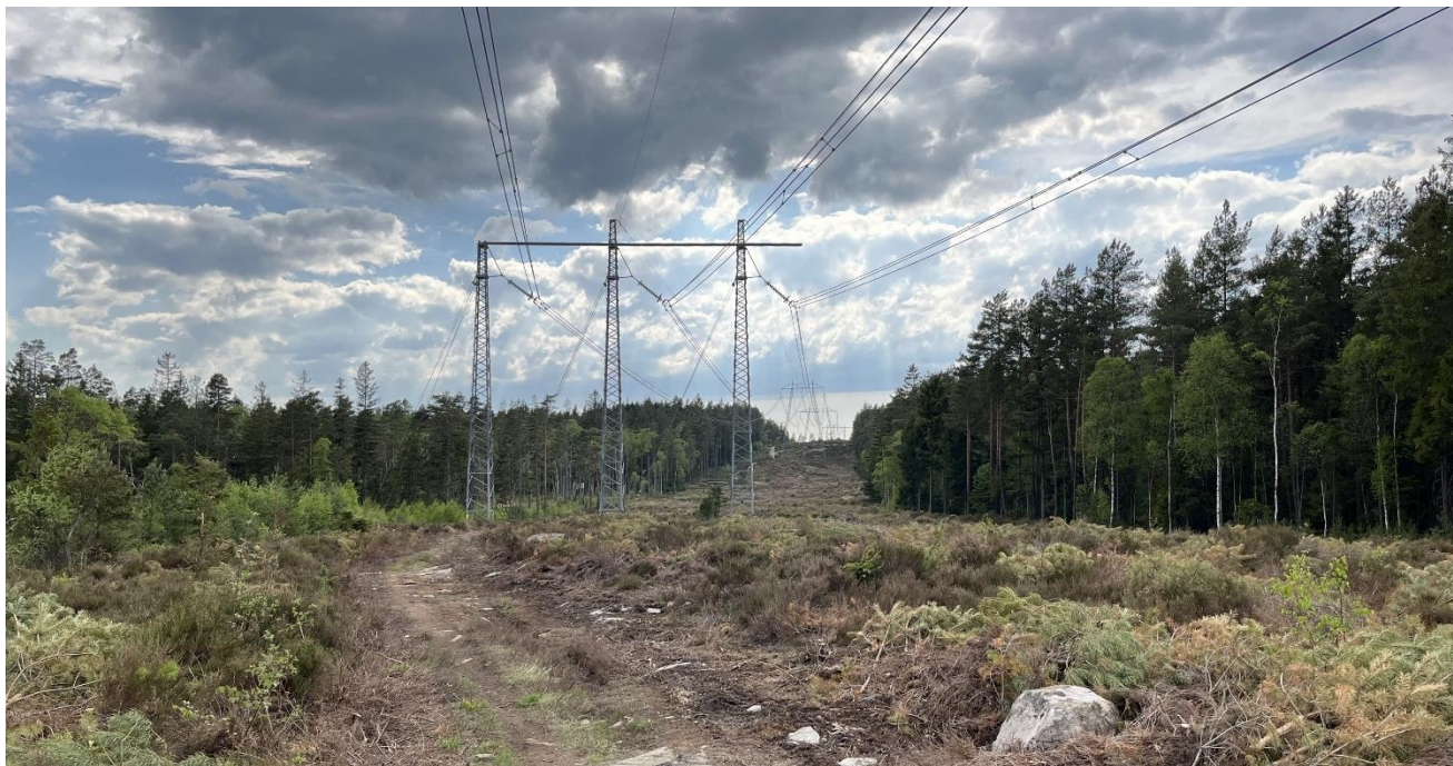
Figur 12. Omgivande landskap utgörs huvudsakligen av skogsmark. Bild tagen vid Hultakulla, mot sydväst. Vid aktuell plats föreslås 130 kV ledningen uppföras norr om befintlig 400 kV ledning, till höger i bild.
