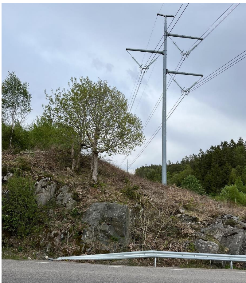
Figur 13. Benarebyvägen korsas av befintlig 400 kV ledning. Bild tagen mot nordöst. Planerad 130 kV ledning föreslås att uppföras norr om befintlig 400 kV ledning, till vänster i bild.
