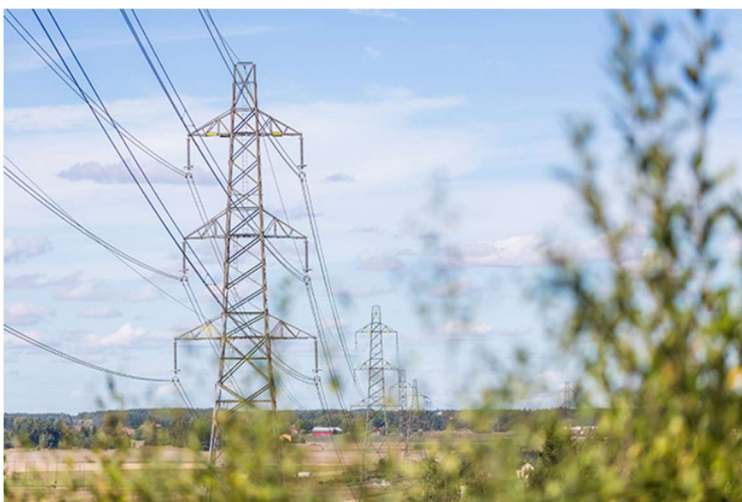
Figur 7. Foto på två sambyggda luftledningar med julgranskonstruktion och två linor i varje fas samt topplina
