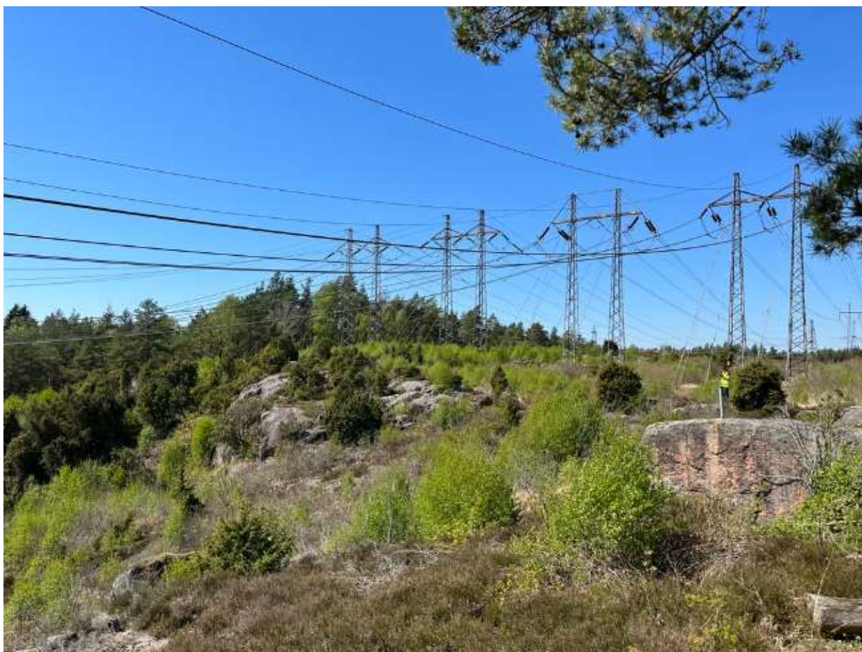
Figur 13. Befintliga ledningar som planeras korsas över med 400 kV och under med 130 kV. Bild tagen ungefär från ny planerad station ZT50.
