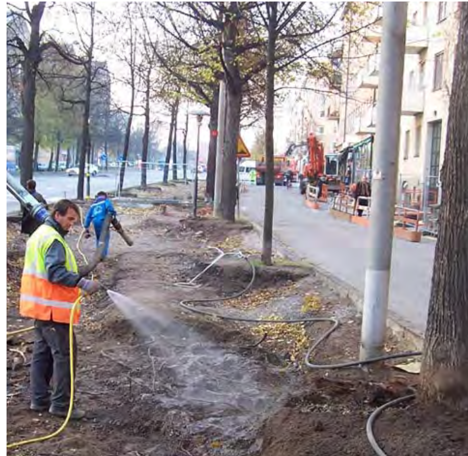
Frilagda rötter vid vakuumschaktarbeten bevattas som skydd mot torka. (Foto: Björn Embrén)
