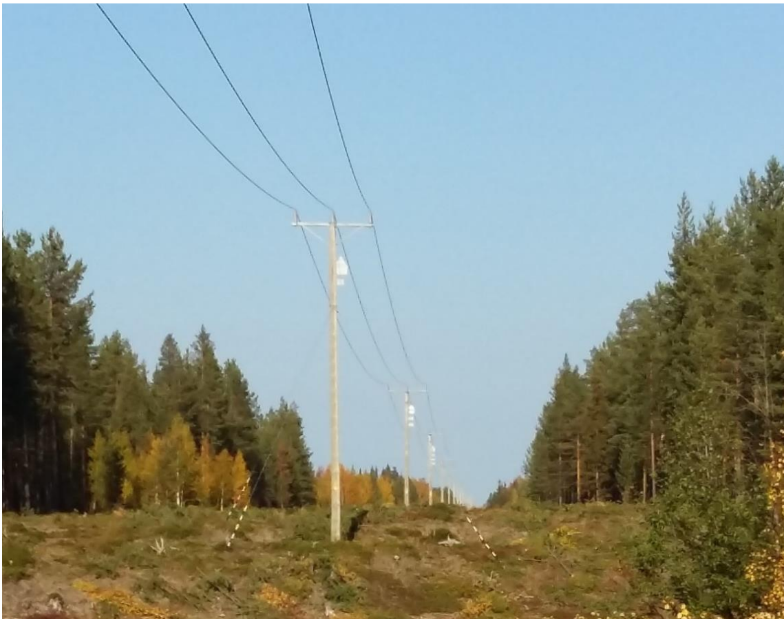
Figur 3 Stolp typ; enbenta trästolpar med horisontellt monterade faslinor.
