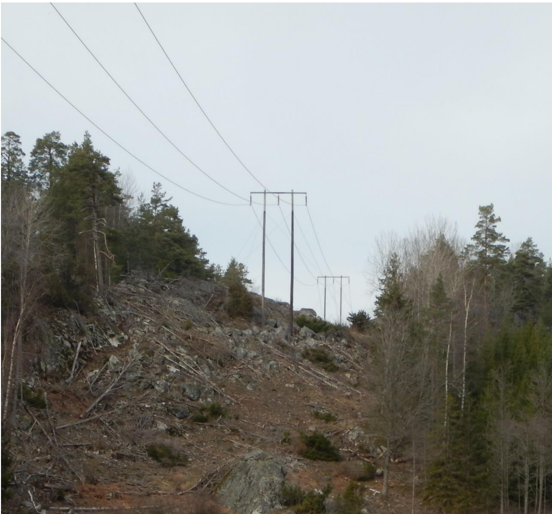
Figur 3. Exempel på ledning i träportalstolpe.
