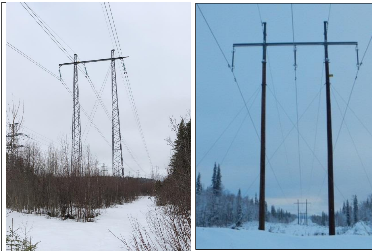
Figur 3. Bild till vänster på 220 kV ledning i portalstolpe i stål. Bilden till höger är en 150 kV ledning i träportalstolpe.
