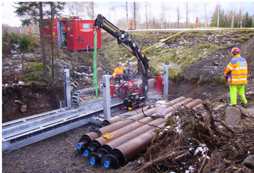
Figur 5. Bilden visar en pågående rörtryckning (hammarborrning) med intelligande foderrör.
