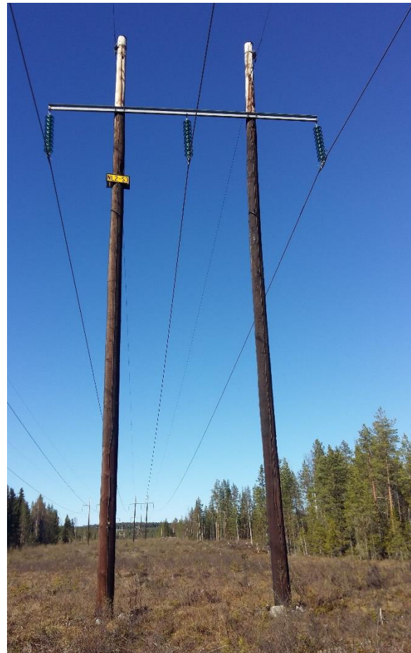
Figur 9. Exempel på stolptyper som kan vara aktuella för 130 kV-ledningar. Från vänster: Fackverksstolpe av stål för dubbelledning och portalstolpar i trä för befintliga 130 kV-ledningar.
