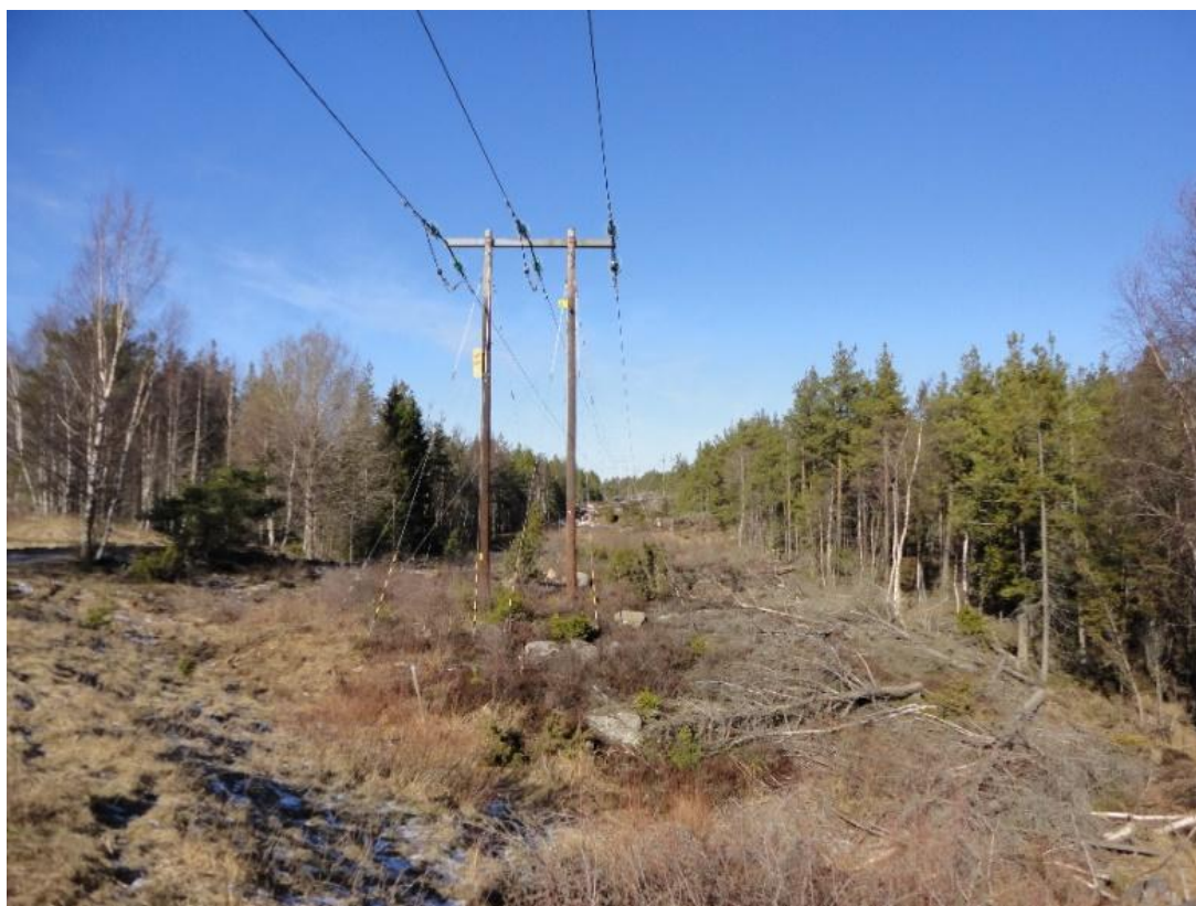
Bild 1. Foto över befintlig skogsgata vid Rudan där befintlig ledning kommer att raseras.
