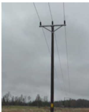
Figur 6. Exempel på trästolpe med stålregel.
