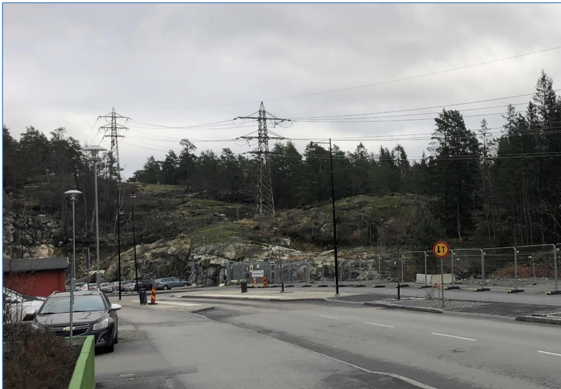
Figur 6. Foto över ledningarna innan ombyggnationen. Rasering kommer att ske av stolpe och ledning närmast i bild. Bilden är tagen vid Tollarevägen i riktning mot öster.
