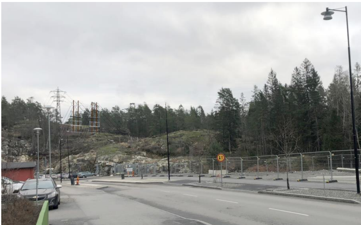
Figur 8. Ledningarna efter ombyggnation. Nya kabelstolpar till vänster i bild. Bilden är tagen vid Tollarevägen i riktning mot öster.
