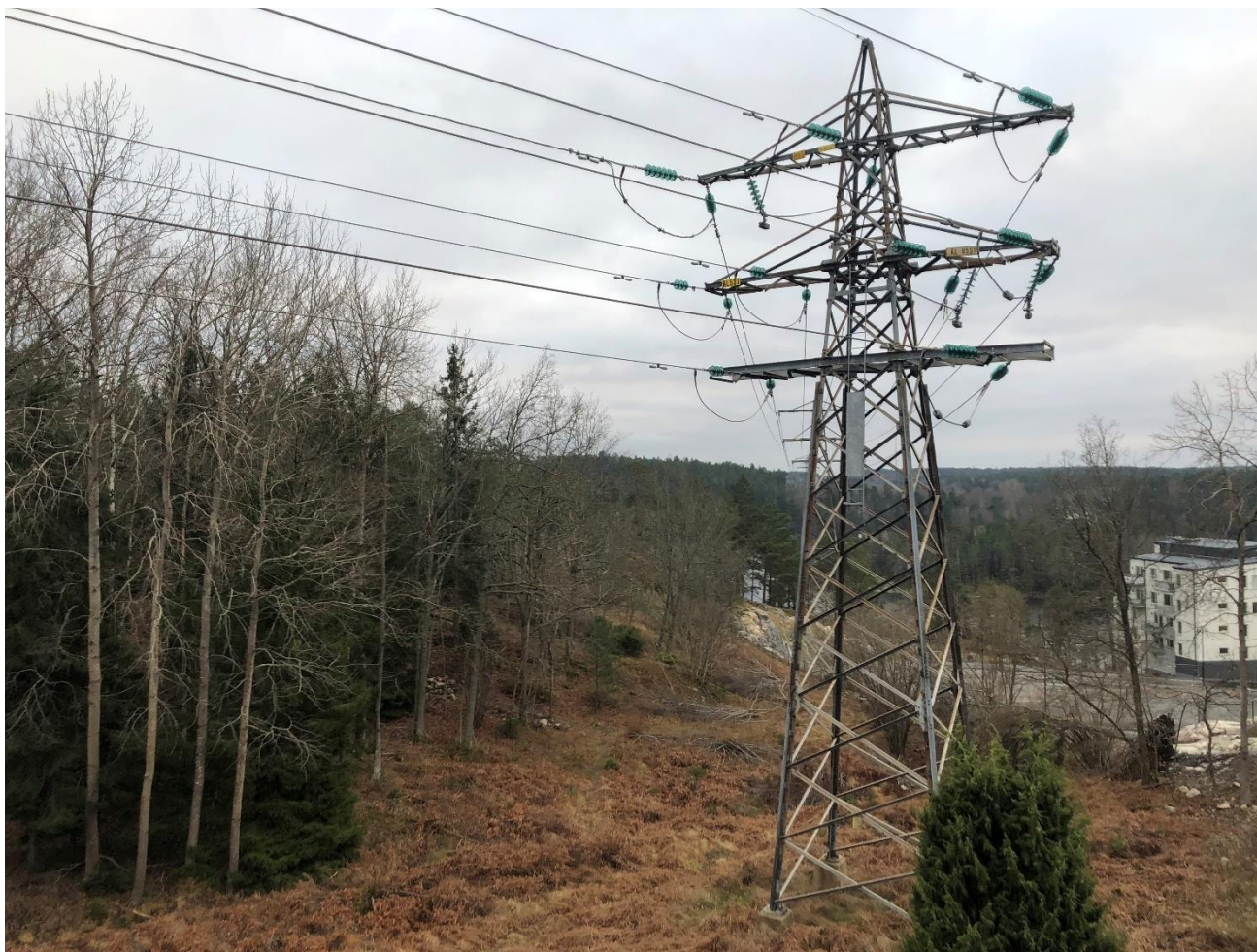
Figur 9. Ledningarna innan ombyggnationen. Rasering kommer att ske av stolpe och ledning närmast i bild. Bilden är tagen vid Tollarevägen i riktning mot söder.
