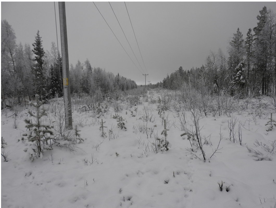
Figur 9. Bilden visar idag befintlig 40 kV ledningsgata som den nya ledningen byggs invid.
