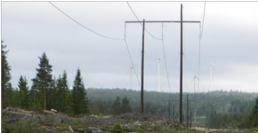
Figur 5. Exempel på 150 kV ledning på tvåbent trästolpe benämns som portalstolpe med enkel topplina.
